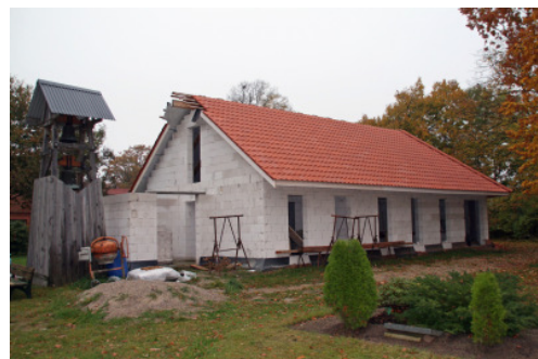
Die Kirche Zweedorf während der Bauphase.
