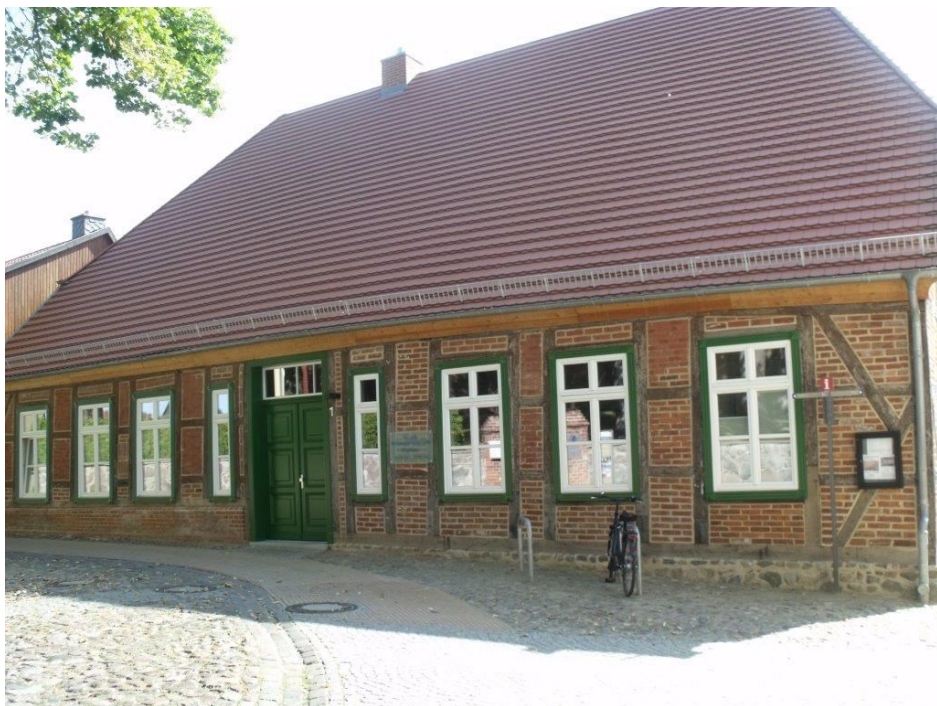
Frisch herausgeputzt: Das Dach des alten Fachwerkhäuses ist komplett neu eingedeckt worden. Fotos: Privat
