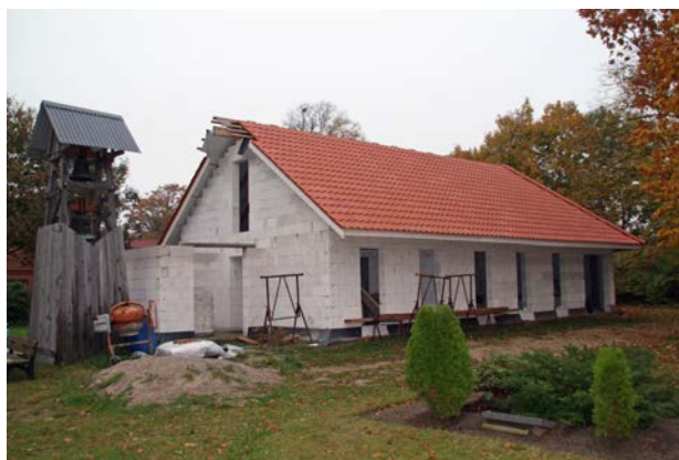
Die kleine Kirche im Bau. Foto: ELKM-Archiv
