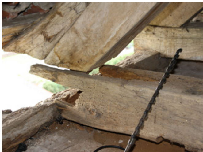
Instandsetzung der Dachtragwerke der Seitenschiffe (Fußpunkte)
