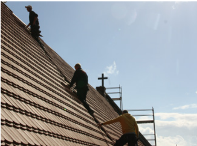
Erneuerung Dachdeckung Mittelschiff (Biberschwanz-Kronendeckung)
