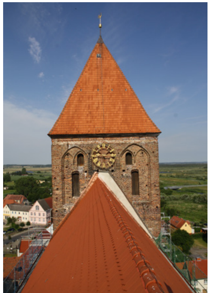
Erneuerung Dachdeckung Mittelschiff (Biberschwanz-Kronendeckung)
