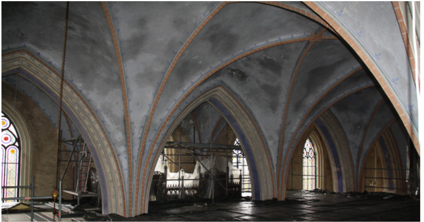
Gewölbesanierung Mittelschiff und südl. Seitenschiff
