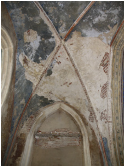
Gewölbe- und Wandsanierung nördl. Seitenschiff
