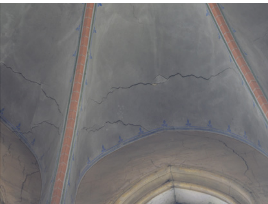
Gewölbe- und Wandsanierung Chor
