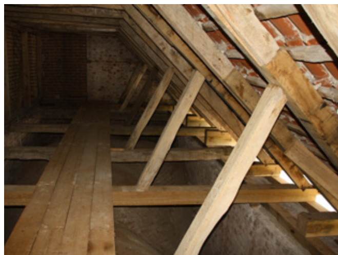
Instandsetzung der Dachtragwerke der Seitenschiffe (Fußpunkte)
