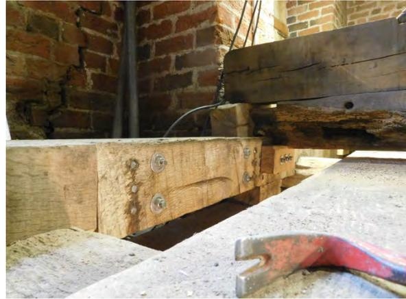
Detail saniertes Holzkonstruktion / Auflager Glockenstuhl
