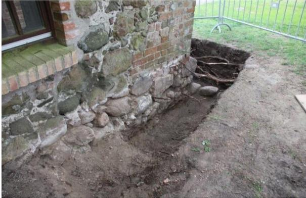
Abb. 17: Gründungsschäden durch Wurzelwuchs
