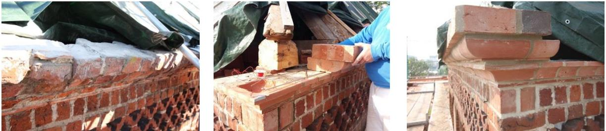
Abb. 23-25: Wiederherstellung Mauerwerksgesims mit neuen Formziegeln
