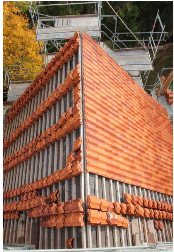
Abb. 21: Draufsicht bei Eindeckung mit Hohlfalzziegel
