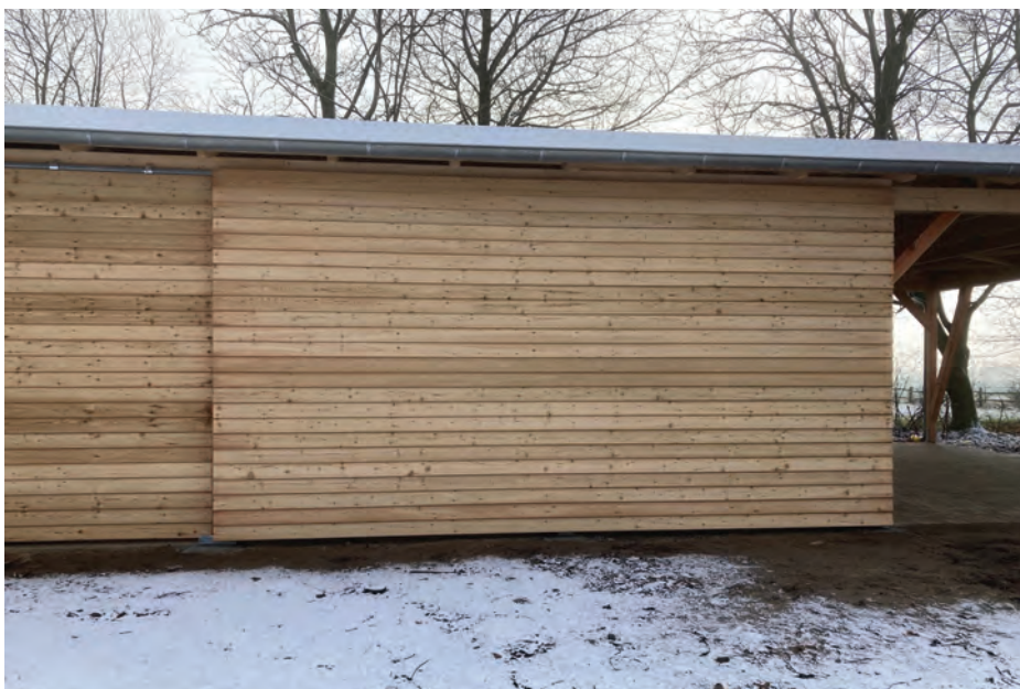
Die Seitenelemente des neuerrichteten Dachs lassen sich verschieben und erweitern so zusätzlich die vielfältigen Nutzungsmöglichkeiten.
